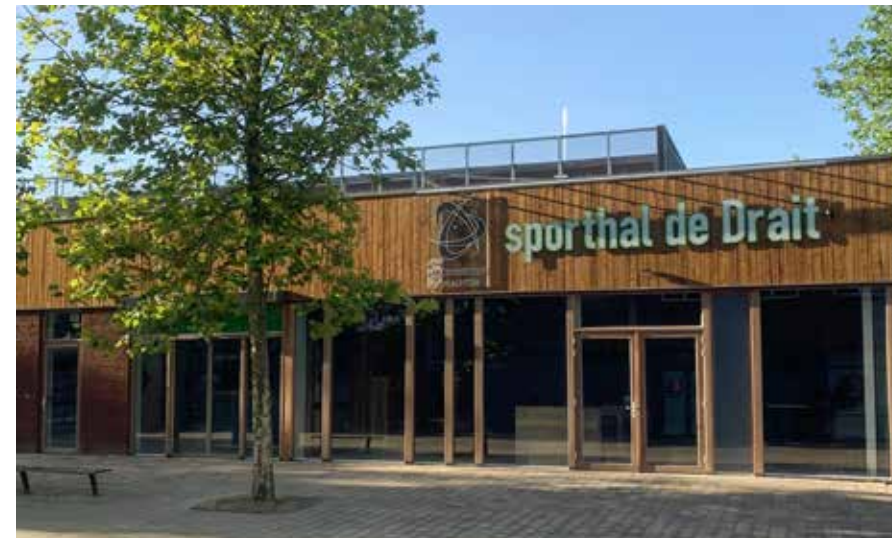
Met de bouw van sporthal De Drait bewijzen de gemeente Smallingerland en Wind Design + Build dat circulaire bouw uitstekend kan samengaan met een aantrekkelijk ontwerp én vergroening van de omgeving.
