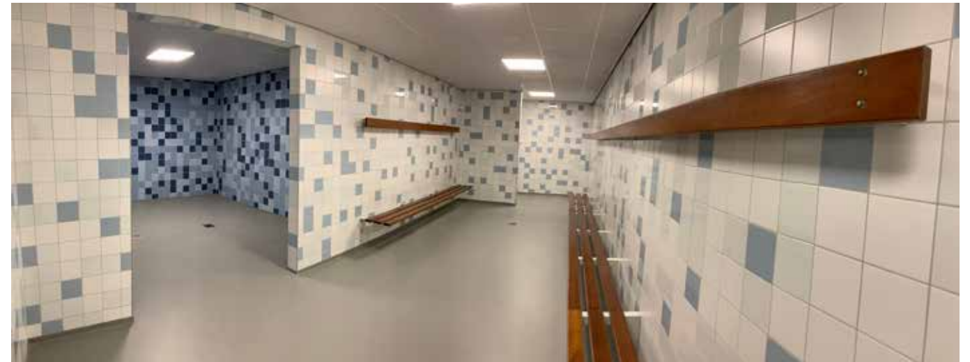
De kleedbanken en haken uit de oude sporthal zijn opgeknapt en opnieuw toegepast in de nieuwe sportaccommodatie.
