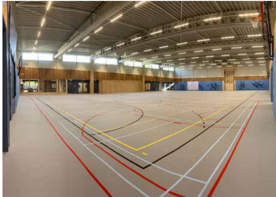
Inmiddels is ook de sportvloer aangebracht.
